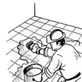
**5** Dopo circa 60 minuti dalla stesura del prodotto, provvedere alla rimozione, con uno straccio impregnato di diluente nitro, di eventuali residui di **PROTECH BALCONY**, causati dal ristagno del prodotto sulla superficie della pavimentazione. Dopo la stesura del prodotto si potrà notare l'azione idrofobizzante del prodotto, caratterizzata dal tipico "effetto fiore di loto".
